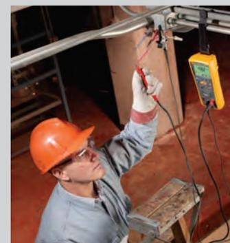
O suporte magnético para medidor deixa as duas mãos livres para que você se concentre em fazer as medições com segurança.
