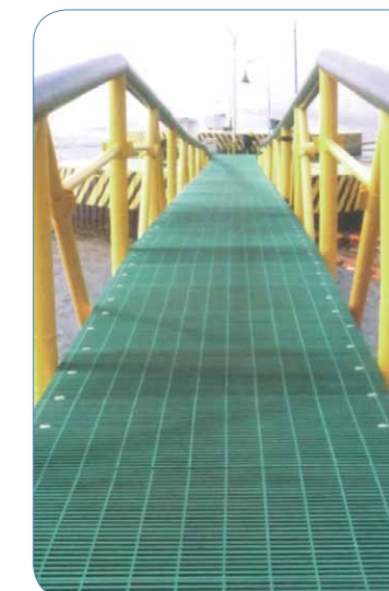
Aplicação de grade off-shore. Ilha D'água - RJ. 1999.
