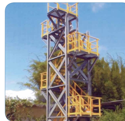
Torre em fibra de vidro (10m de altura)
