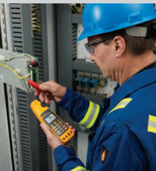
Processo de medição e outras automações de sinais de 4 a 20 mA sem interrupção do circuito.
