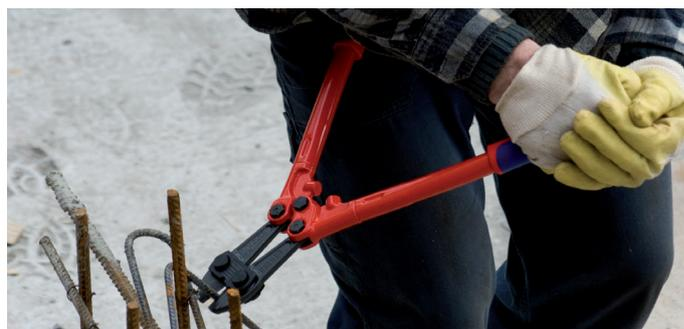
Encosto forjado com elemento de amortecimento: amortece confortavelmente o impacto do corte
