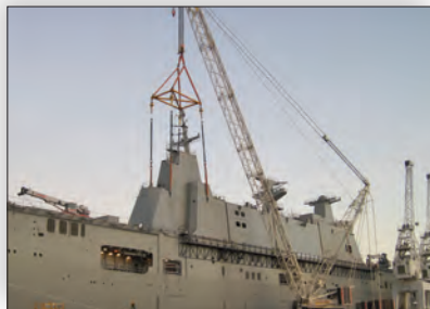
Íçamento sincronizado e posicionamento de carga
