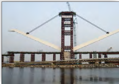
Íçamento com controle de precisão de alta capacidade.
